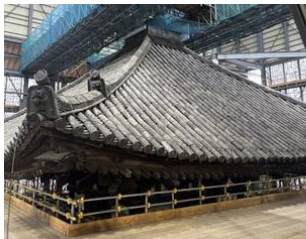
損傷が顕著な本瓦
