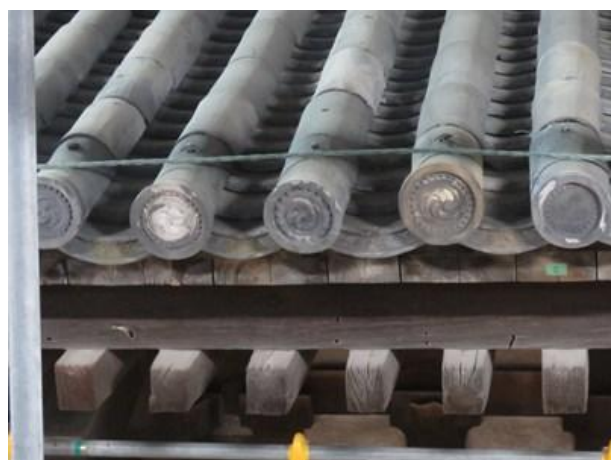
損傷が顕著な本瓦
